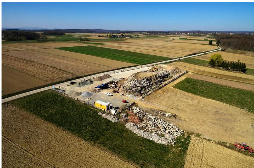
Slika 3. Reciklažno dvorište građevinskog otpada Radošević d.o.o. u Predavcu
