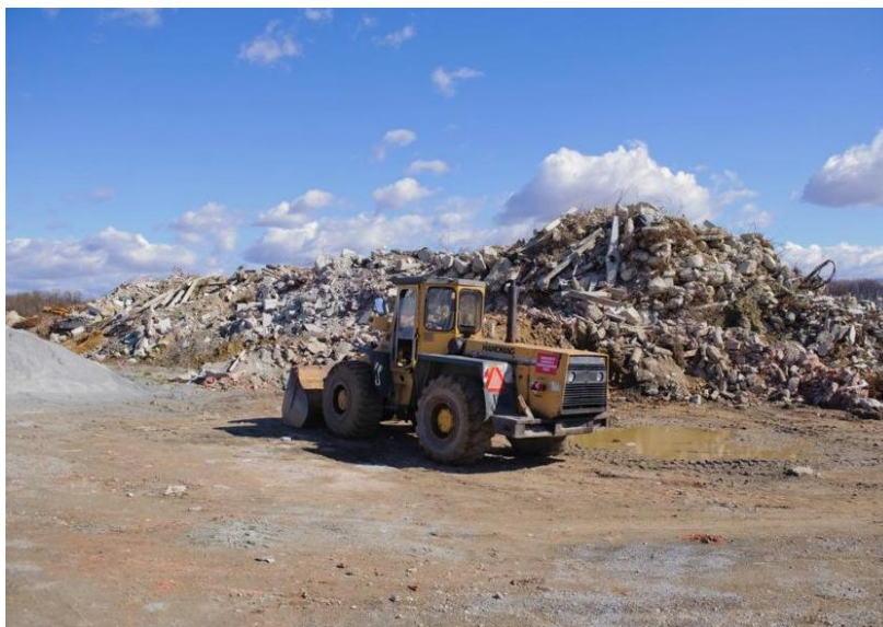
Slika 6. Reciklažno dvorište građevinskog otpada Radošević d.o.o. u Predavcu
