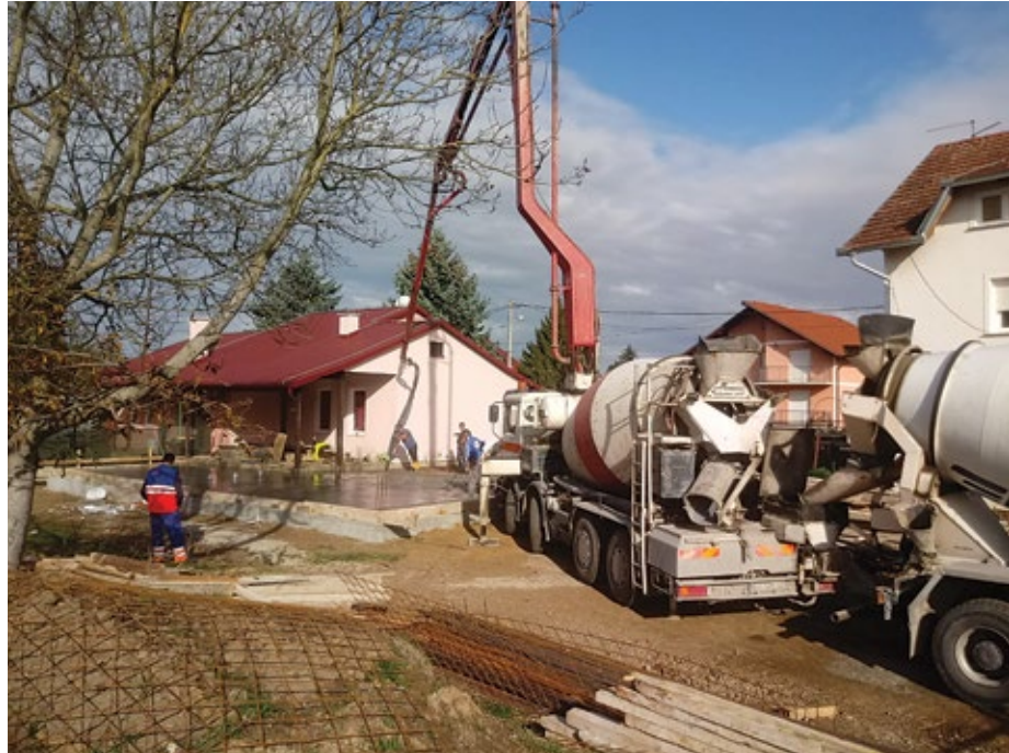
Početak radova na rekonstrukciji i dogradnji vrtića Palčica
