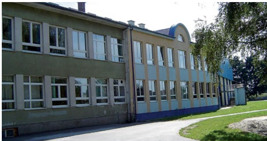
Osnovna škola u Rovišću uskoro će biti temeljito obnovljena
