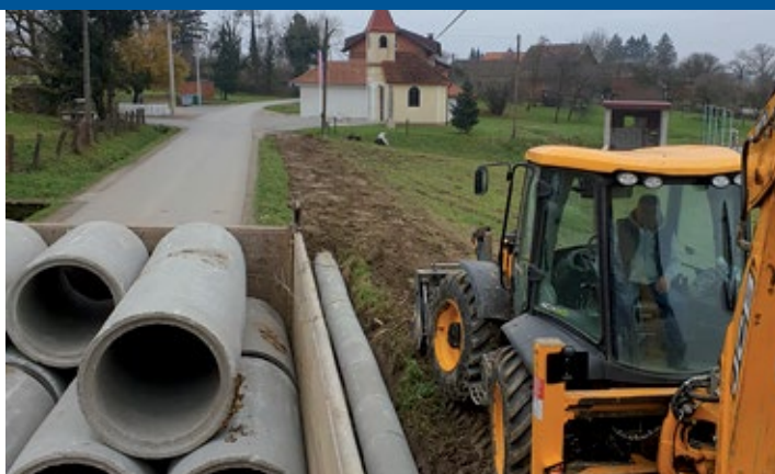
Zacijevljivanje putnog jarka u Žabjaku
