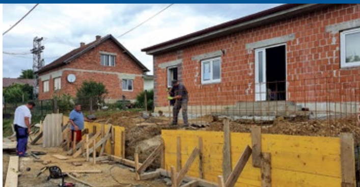
Radovi na Društvenom domu u Kakincu
