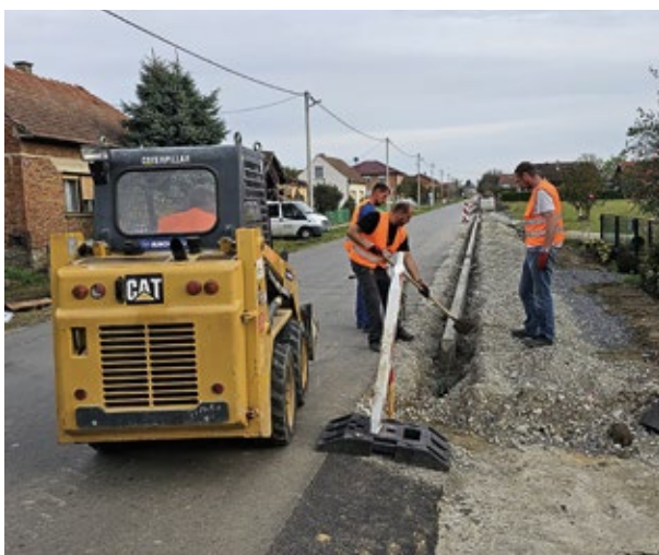
Izgradnja nogostupa u Podgorcima, III. faza
