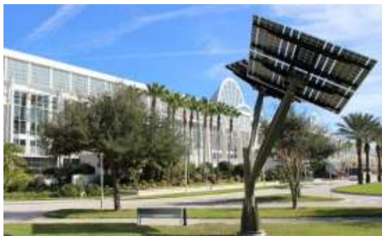
Solarni panel na javnoj površini Conventin center, Orlando, SAD, spotlightsolar.com
